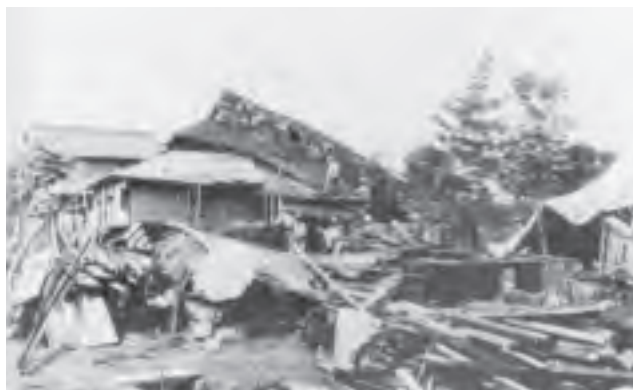
▲江農地方激震被害
