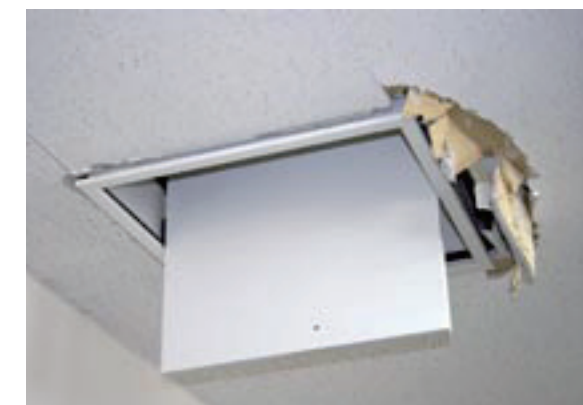
本来火災時のみ開放する排煙口も震度6強の強い揺れにより誤作動
