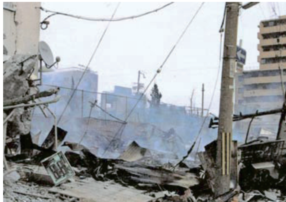
大火災が発生した神戸市長田区地域は、まるで戦禍を被ったような悲惨な状況であった。これら火災は、停電後に一時的に再開された電気の復旧による漏電等が発生の原因になったと言われている。また、水道が断水していたため、消火活動が十分に行えなかった。
