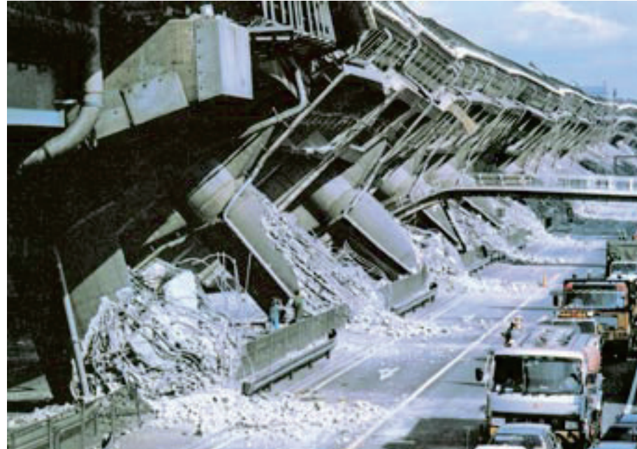
阪神高速道路は3号神戸線が神戸市東灘区深江本町付近で約640 mにわたり倒壊したのをはじめ、5ヵ所で落橋があり長期間通行止めとなったため、周辺国道が渋滞した。
