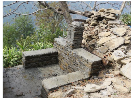
建設中の共同の水道の蛇口。 子ども用に低い蛇口も取り付けられている。
