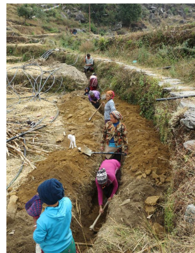
水を引くパイプの施工作業に励む女性住民。
