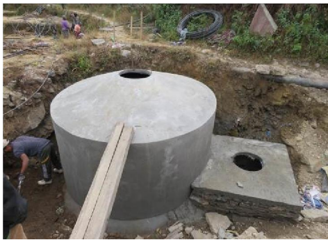
水源の水を貯めるタンク。 (10,000 リットル、72 世帯分)
