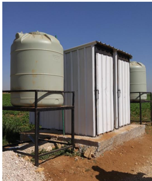
設置された水タンクとトイレ ©日本赤十字社
