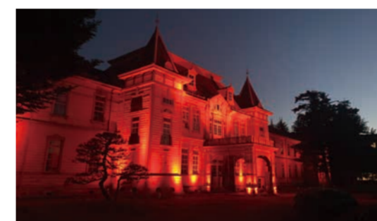
【重要文化財 旧米沢高等工業学校本館(山形)】
