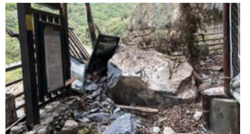
落石により通行ができなくなった太魯閣渓谷の遊歩道 ©台湾赤十字組織
