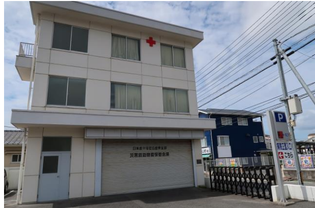
災害救助物資保管倉庫 (三原赤十字病院)
