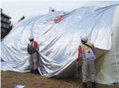
▲寒さのため dERU に断熱シートを掛ける
