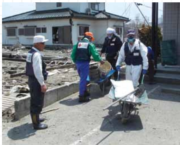
▲被災地でのがれき撤去作業にはマスクが欠かせない
