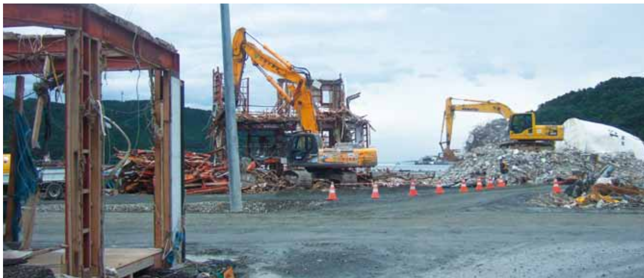
▲復興にむけて瓦礫の撤去が進む（女川町）
