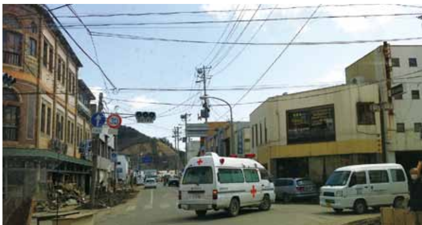
▲28日道路に瓦礫は無くなるが、信号はまだ復旧していない
