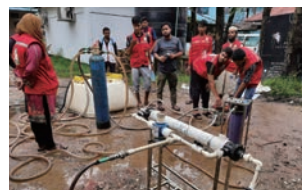
研修を受けたバングラデシュ赤新月社のボランティアが給水キットを設置している様子 ©日本赤十字社
