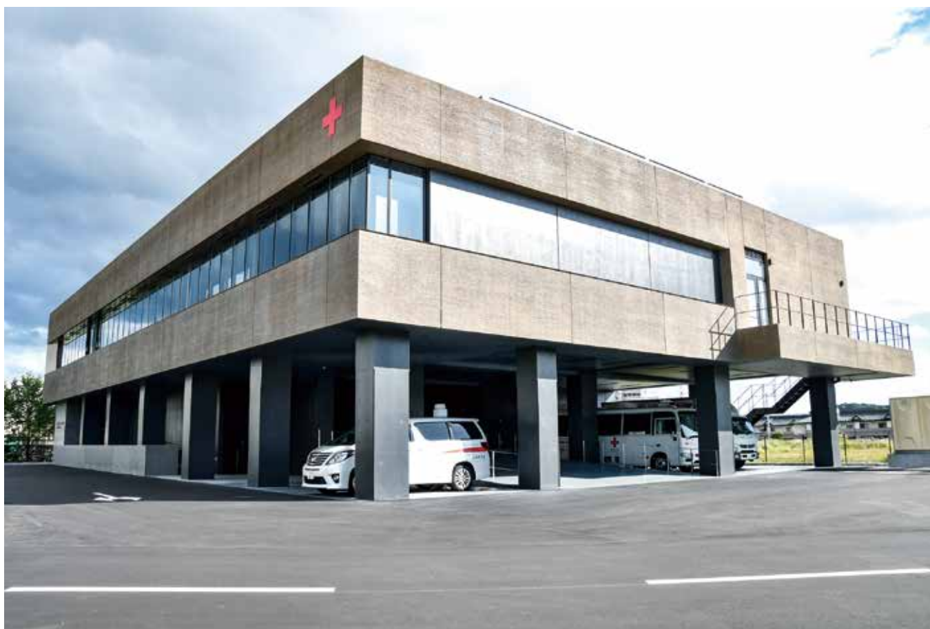
日本赤十字社宮城県支部 社屋兼ロジスティクスセンター（令和5年9月竣工）
