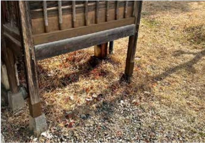
改修工事後（傷んだ外装、損傷の激しい土台を補強した）
