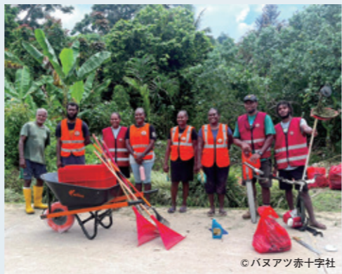
排水溝清掃活動をユース主導で実施するバヌアツ赤十字社 サント島支部ユースボランティア
