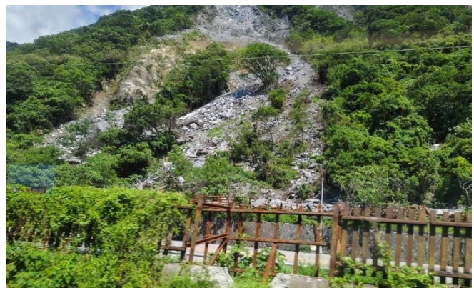
花蓮県の移動中、電車から見られた土砂崩れの様子
