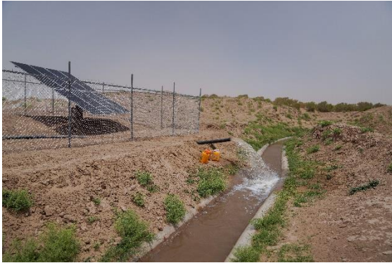
設置されたかんがい用太陽光発電ポンプシステム © IFRC
